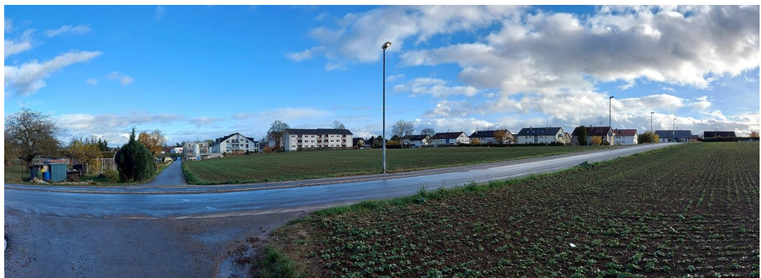
Abbildung 17: Foto, Blick von Nordwesten (Baldauf Architekten und Stadtplaner GmbH), 20.11.2023
